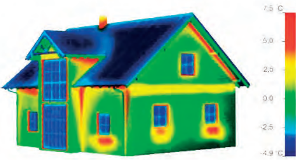
Evidenze termografiche - Thermografische Beweise
